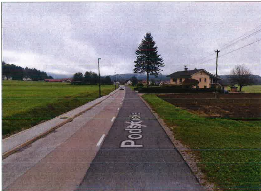
Slika 8: trasa lokalne ceste LC-067011 z enostranskim pločnikom širine 1,20 m ter zaledno betonsko kanaletto za zbiranje zalednih površinskih voda.
